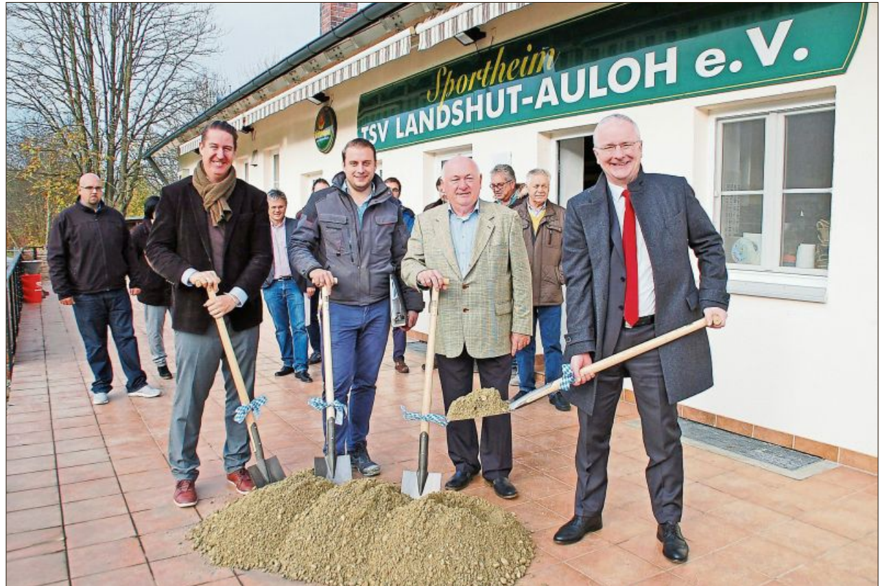
Beim symbolischen Spatenstich (von links) Architekt Mario Mirbach (PURE Gruppe), Florian Schaak vom gleichnamigen Bauunternehmen, Vorsitzender Erich Süßl und Oberbürgermeister Alexander Putz. Foto: sig
