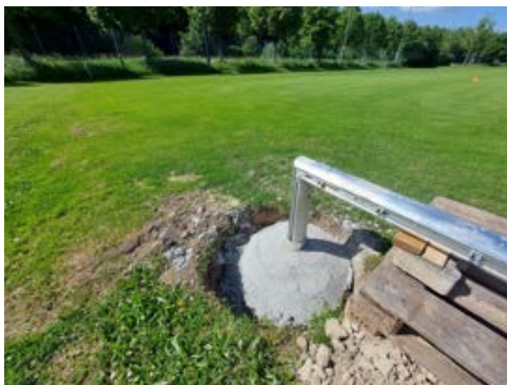
Die Tore am Nebenplatz erhielten ein neues Fundament
