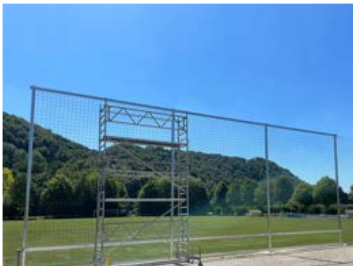
Errichtung / Erweiterung des Ballfangzaunes
