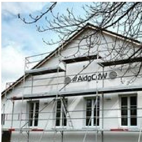
Fassadenarbeiten am Vereinsgebäude
